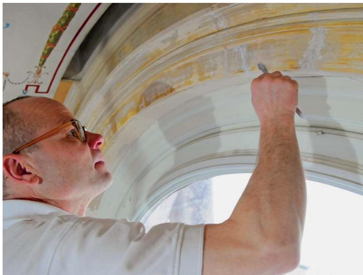
Der Stuckateur André Glauche schließt abgenutzte Stellen eines Rundbogens der Semperoper.
